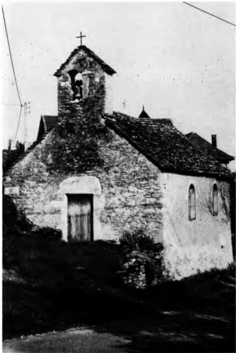
Capilla de Collonge. Este edificio prerrománico sólo ha sufrido ligeras transformaciones. Ha conservado su tejado de pizarra, y probablemente sus dimensiones originales ( 10,15 \times 6,70 m en exterior), que le otorgan una superficie interior de unos 40 \text{ m}^2 . Fue construida a la medida del caserío de Collonge, en época carolingia. La capilla está consagrada a san Lorenzo. (© T. Bellion.)
